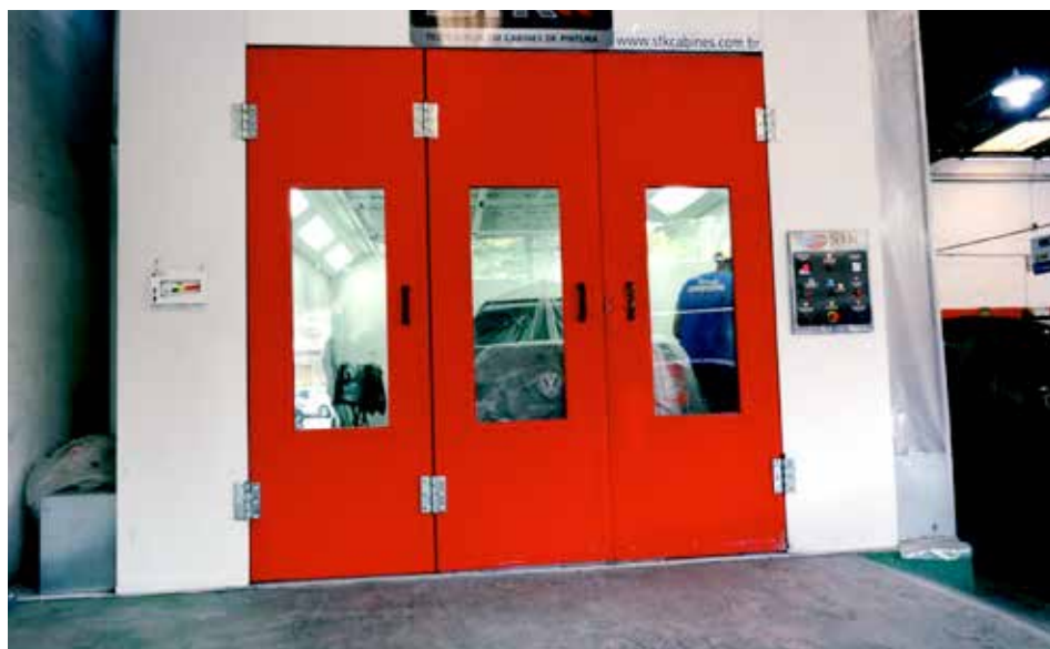
Figura 7 – Cabine de pintura
