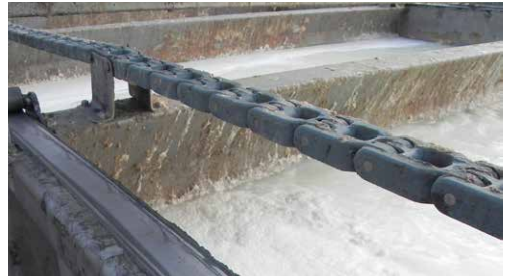
Figura 21 – Flotador para separar partículas líquidas ou sólidas de uma fase líquida Fonte: Autores, 2014
